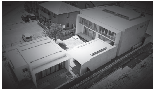
写真－34 当該案件俯瞰全景写真
