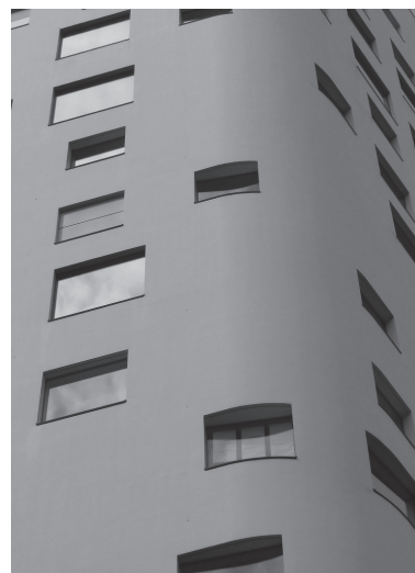
写真-9 SA ビルディングの目地消し工法実施例
