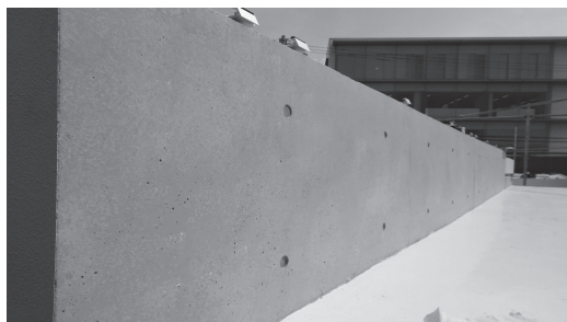
写真-13 本施工の状況
