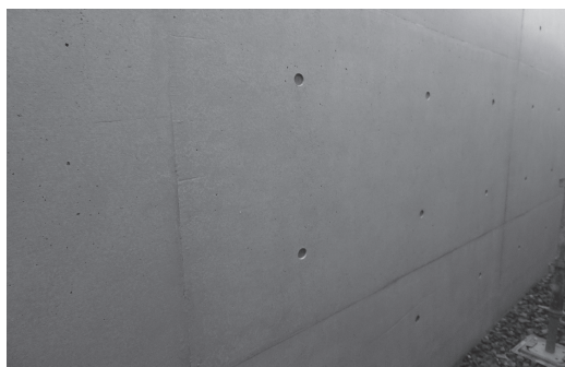
写真-14 本施工のアップ
