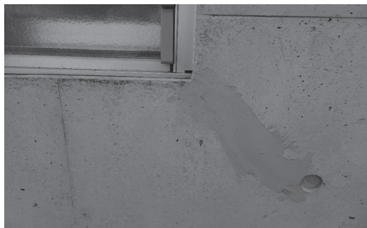
写真-11 カチオンタイトモルタルの施工後の状況
