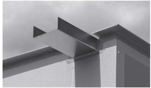
写真-32 庇フラットバー1
