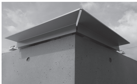
写真-18 アルミフラットバー笠木の取り付け2
