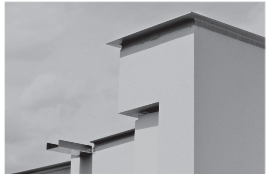
写真-33 庇フラットバー2
