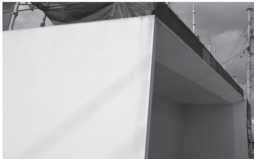
写真-15 施工前の白色塗装部
