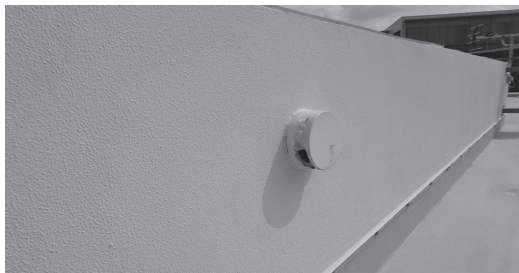
写真-16 インターリッチ施工後の状況
