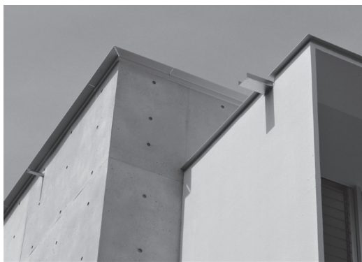
写真-28 ボルトガードAFとインターリッチのコントラスト1
