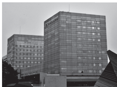
神戸某ビルの施工前の状況
