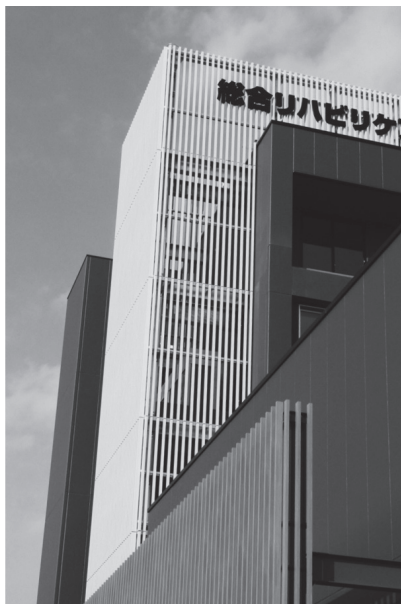
写真－9 南面の状況
