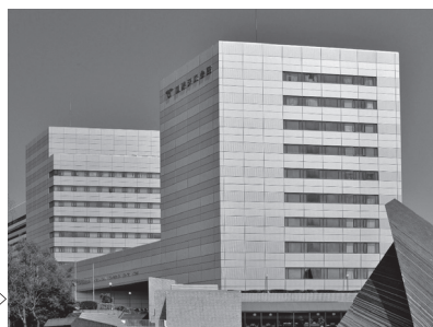
同左、プラチナシルバー施工後の状況
