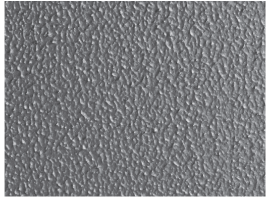
写真-23 同クリヤーの施工
