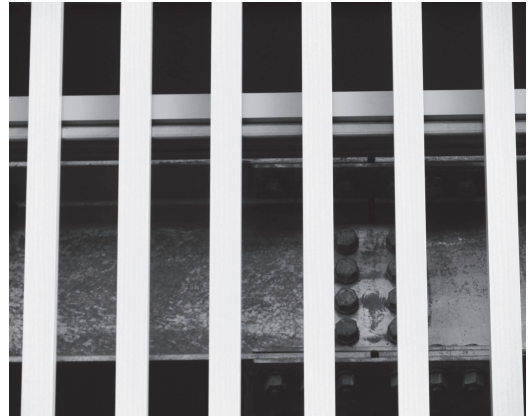
写真-15 薄い木目調ルーバー
