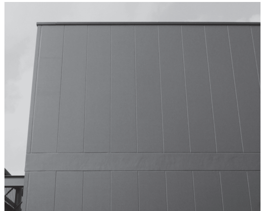
写真-17 ALC 版の従来の塗装工法
