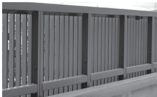
写真－12 室内側から見た北面の状況
