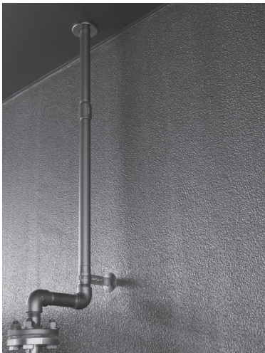
写真-22 同メタリックの施工
