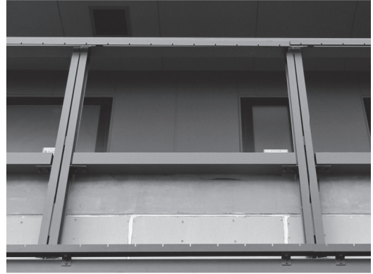
写真-7 下地の施工(遠景)
