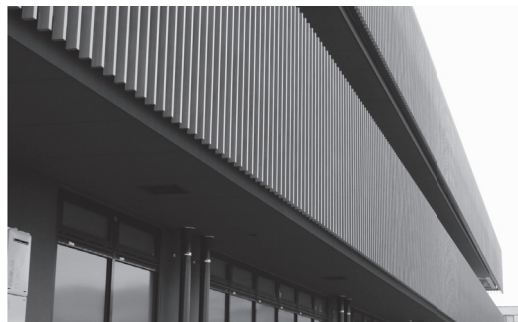
写真－11 北面の状況
