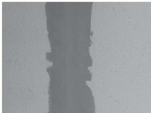
写真-20 同カチオンタイトモルタルFの施工
