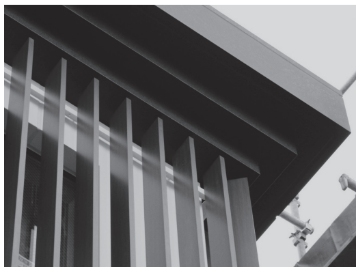
写真-7 縦ルーバー上部と笠木部分
