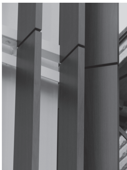
写真-8 縦ルーバーのアップ(1)
