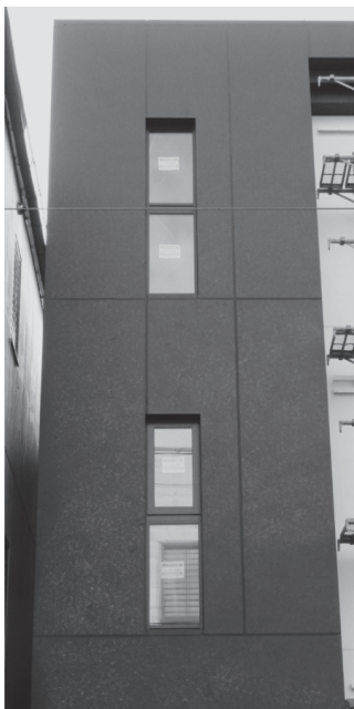
写真-2 クランブルパネル全景
