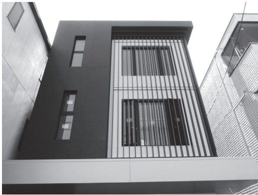
写真-1 正面外壁の全景
