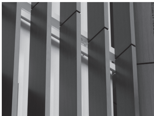
写真-9 縦ルーバーのアップ(2)
