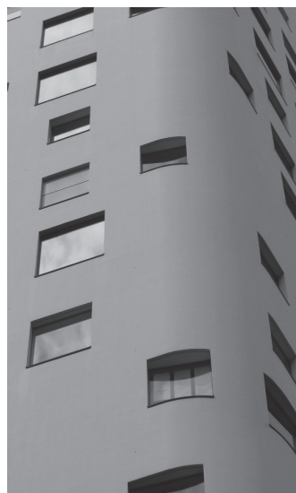
写真-2 目地消し工法の適用例(青山)
