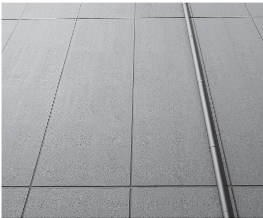
写真－14 目地消し部分の塗装状況
