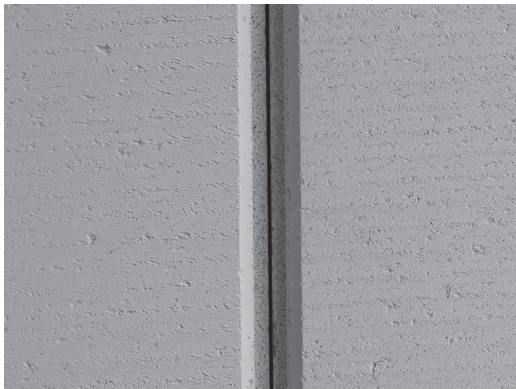
写真-9 表しシール セメダイン EXCEL II 施工部分のアップ
