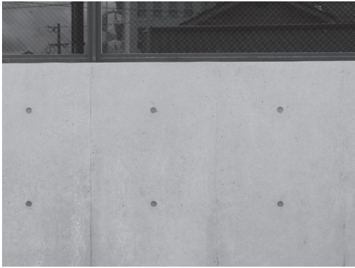
写真-20 ポルトガード AF エイジングの施工 (1)
