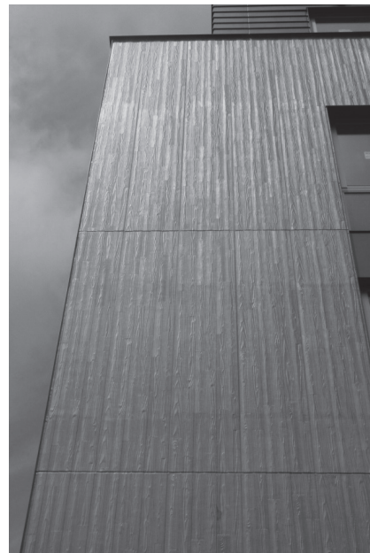
写真-32 目地消し効果による彩実の外壁としての一体感
