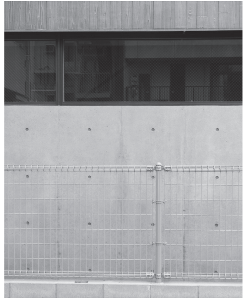
写真-21 ポルトガード AF エイジングの施工 (2)
