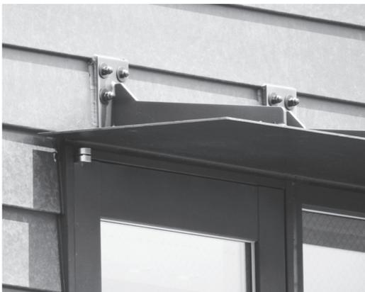
写真-47 アルミ庇の施工状況(アップ)
