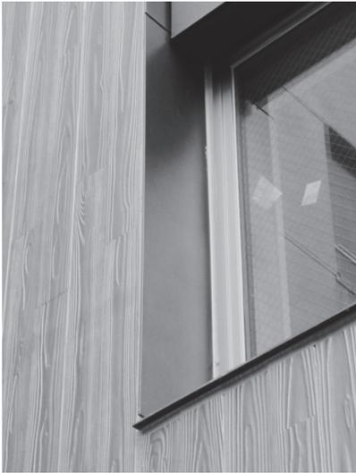
写真-40 サッシ四方見切・水切りの施工状況(2)
