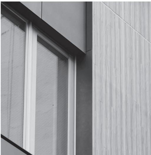
写真-41 サッシ四方見切・水切りの施工状況(3)
