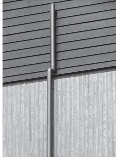
写真-52 ビルアルミ丸たてといの施工状況(1)
