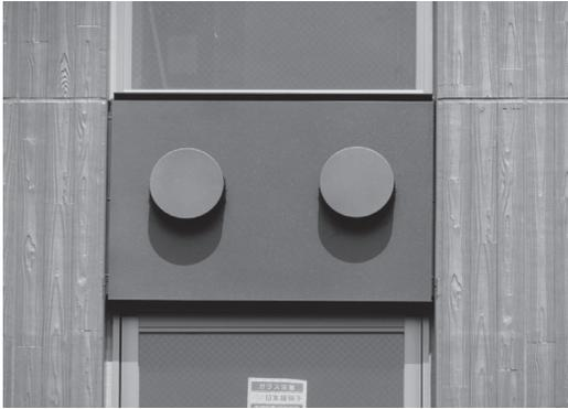
写真-65 象嵌パネル付のベントキャップの施工状況
