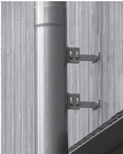
写真-51 ビルアルミ丸たてといの留付け状況(2)
