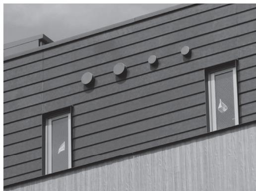
写真-62 サカロックヨロイ付のベントキャップの施工状況
