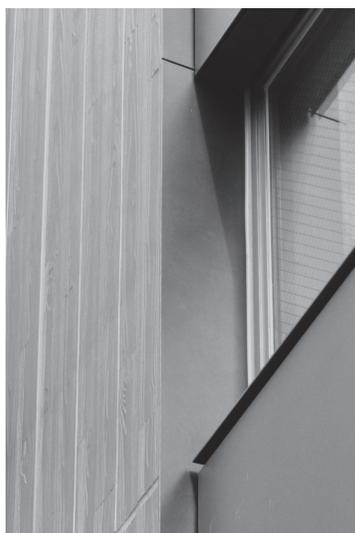
写真－39 サッシ四方見切・水切りの施工状況(1)
