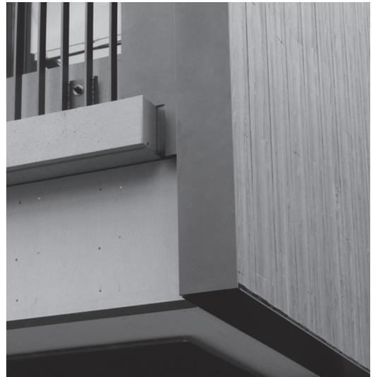
写真-43 壁見切の施工状況(下部)
