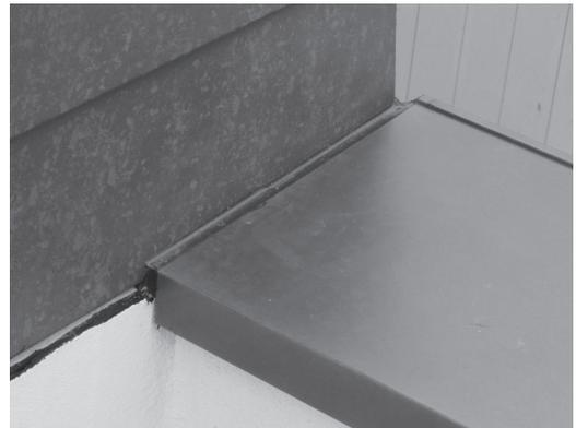
写真-44 アルミ笠木の施工状況(1)
