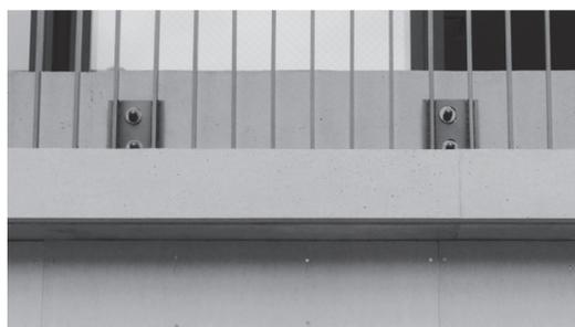
写真－56 スチール製手すり固定部分
