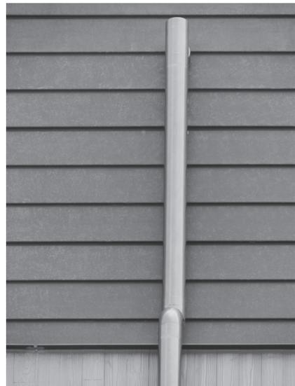
写真-53 ビルアルミ丸たてといの施工状況(2)
